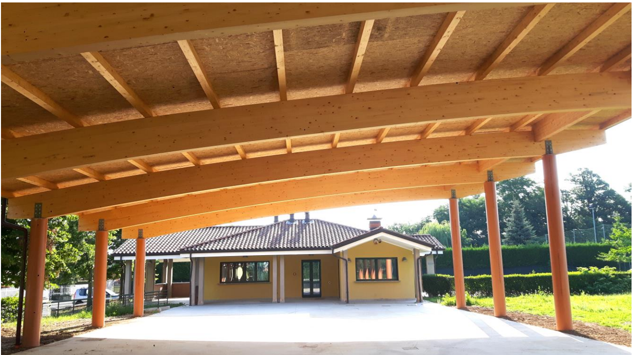
INTERNO – VERSO EST
