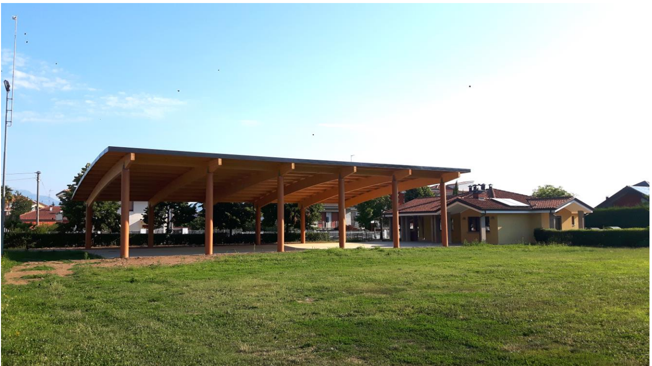
ESTERNO – SUD OVEST
