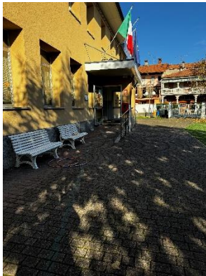
Rampa non conforme
