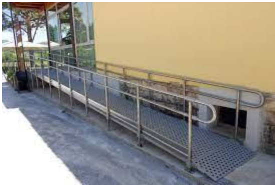
Esempio parapetto per rampa disabili
