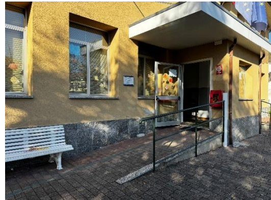
Rampa non conforme
