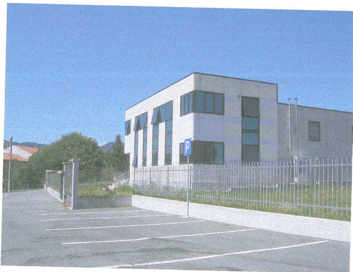
Fig. 9 – Quirico macchine transfer, strada comunale Callona (Area industriale a nord)
