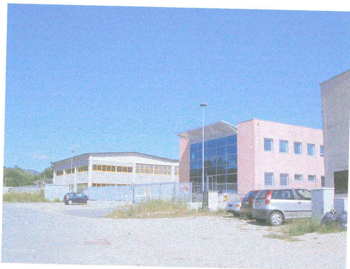
Fig. 8 – Idral rubinetteria (Area industriale a nord)
